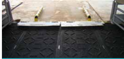
Figura 22. Rampa com superfície metálica articulável para evitar a formação de vão quando os suínos se deslocam para o embarque ou desembarque. Esta estrutura em dobradiça pode ser adaptada em diferentes materiais.
