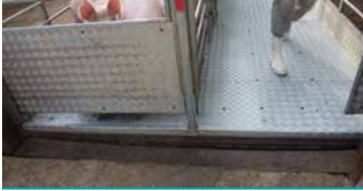
Figura 21. Presença de desnível e piso cimentado escorregadio, entre a carroceria do caminhão e o embarcadouro, dificultam o embarque dos animais
