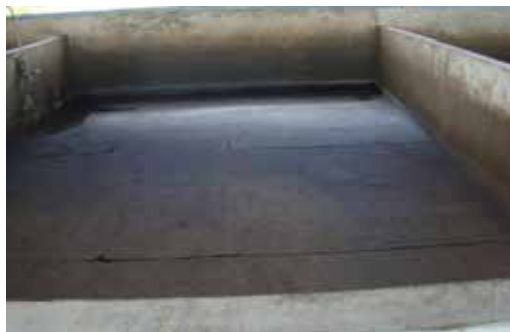
Figura 35. Baia com piso compacto.
