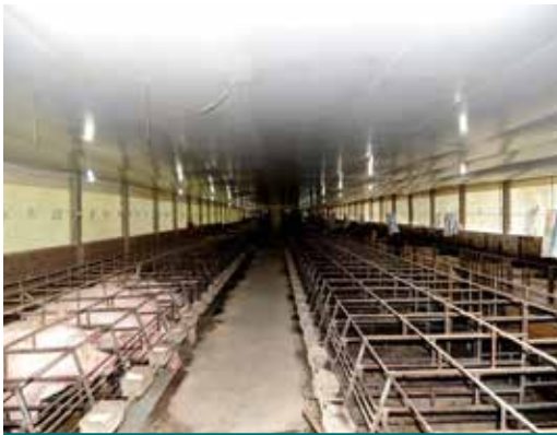
Figura 11. Sistema de pressão negativa: exaustores e forro.
