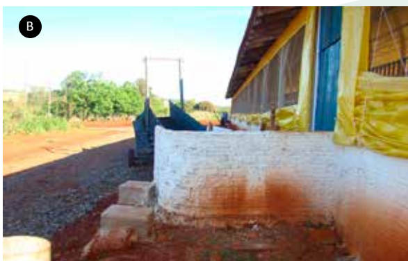
Foto 6 A e B – Embarcadouro localizado no centro da instalação quando a granja possui capacidade para alojamento acima de 500 animais
