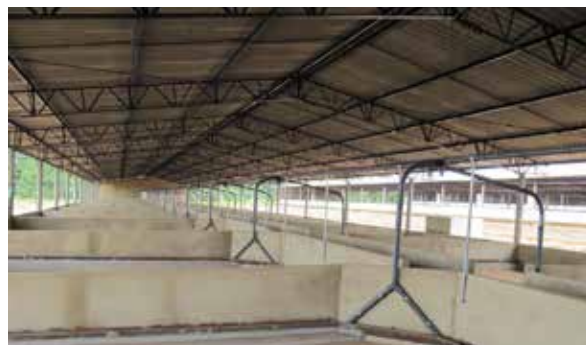
Foto 4 - Instalação preparada para alimentação líquida
